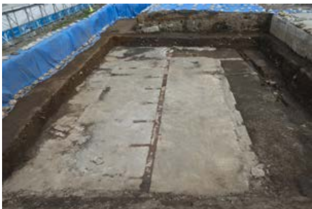
写真 1 陸軍士官学校の建物基礎（西から）
