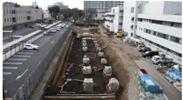
写真1 古代の遺構確認面と周辺の様子（東から）
