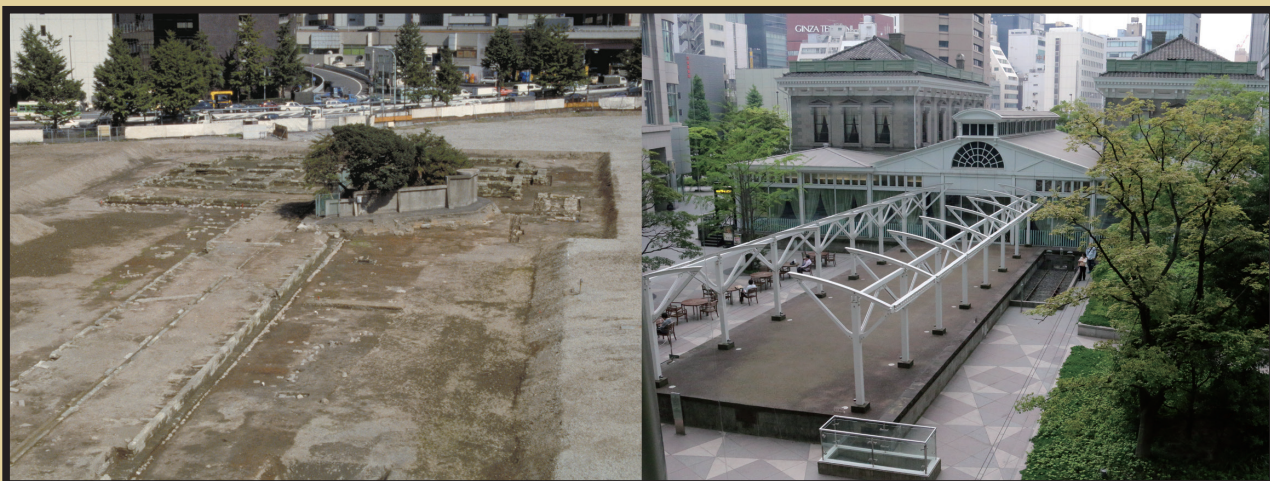
写真1：発掘調査で姿を現した旧新橋駅のプラットホーム（左）と、現在の復元された姿（右）。復元された線路の始点（右写真の駅舎側）には日本最初の路線、新橋～横浜間の基点である0マイルポストがある。
